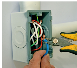
Figura 2 - Ajeite a fiação
