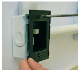
Figura 6 - Parafuse a Base na parede
